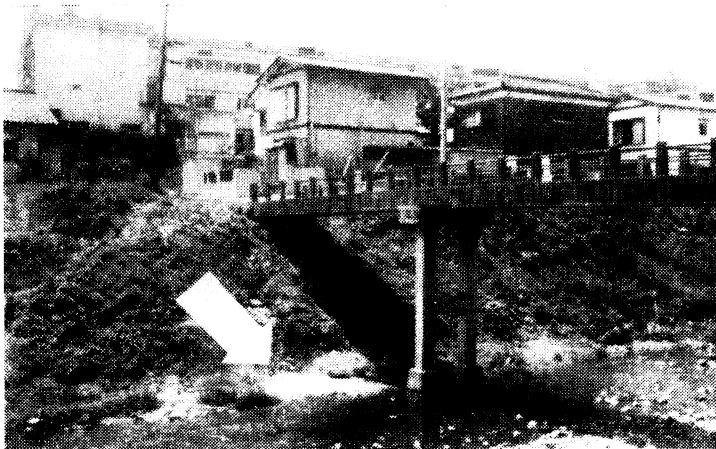
中里橋（千石橋の上流約 200 m）右岸の住宅地からの排水口に白い洗 剤の泡（矢印）が目立つ。未処理下水の流入の例。
