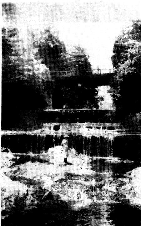
足下田堰堤。これより上流には漁業権は設定されていない。
