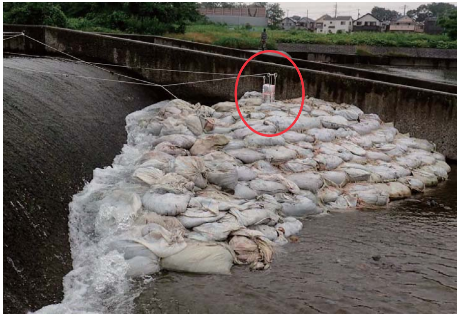
図2 陸上撮影用システムの固定状況
