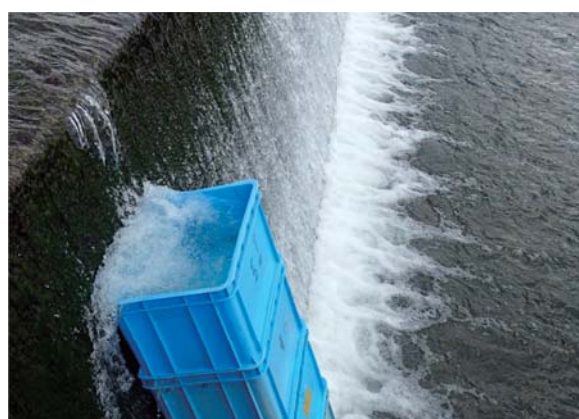
図6 通水中の簡易魚道の様子
