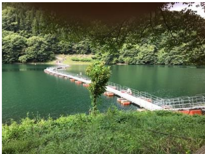
図 1 調査地点の留浦浮き橋
