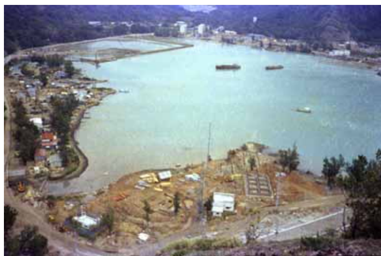
昭和48年5月 建設中の水産センター
