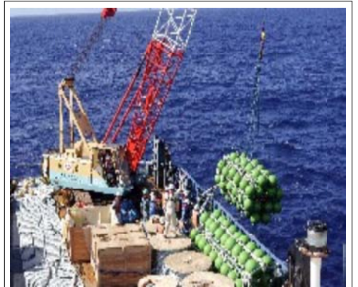
設置されるパヤオ (写真:五洋建設)
