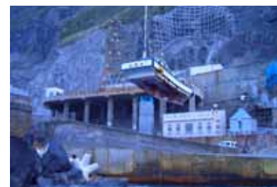
港の未整備により上架される漁船
