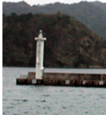
定地水温は、青灯台下水深0.5mで測定
