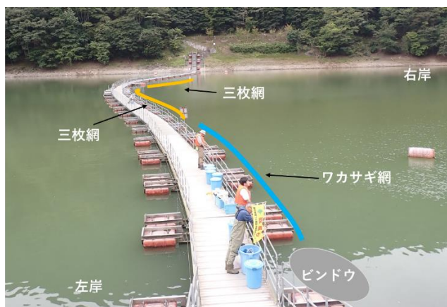
図1 調査を実施した留浦地区の浮き橋
